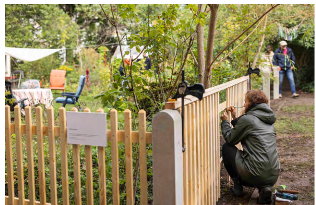
Schaubaustelle Richterstraße in Leipzig, Foto: © Christian Hüller
